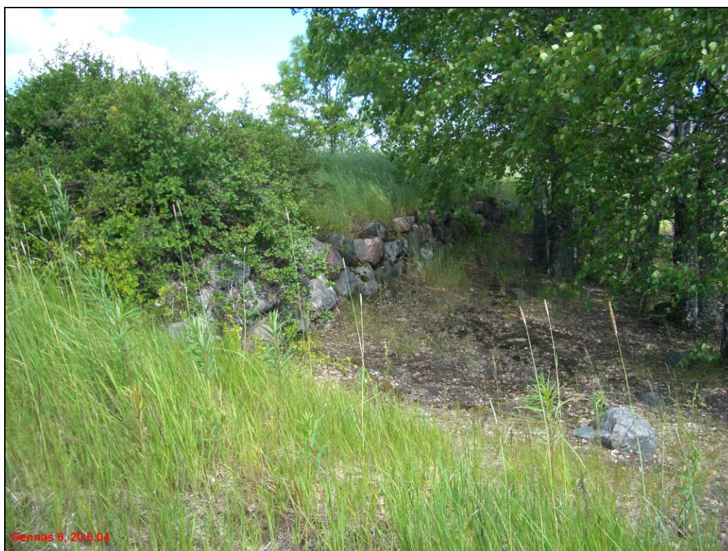
Rakennuksen pohjan kaakkoisreunan kivijalka. Kuvattu pohjoiseen.
